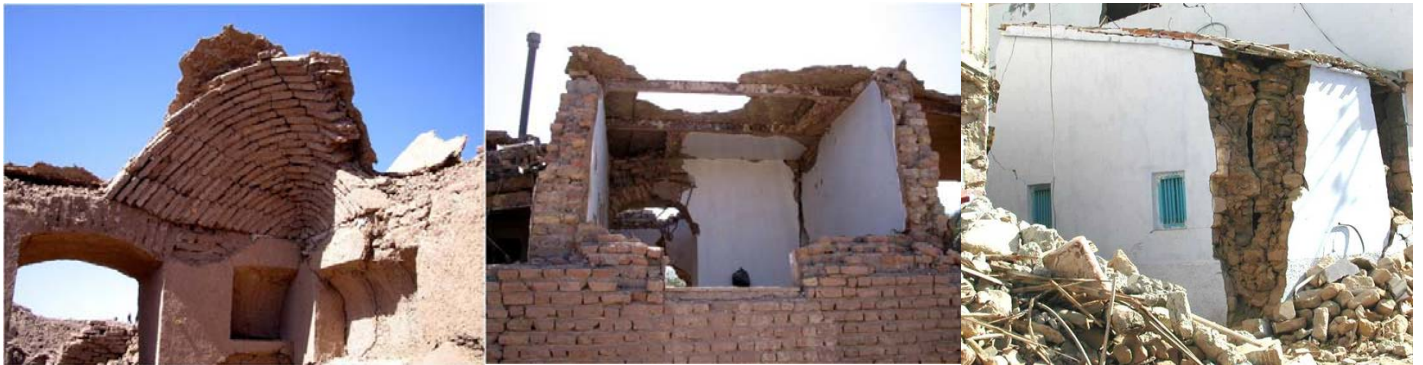
(a) アドベの地震被害(イラン・バム市) (b) レンガ造建物の被害(同バム市) (c) 石積建物の被害(インド・ブジ)
