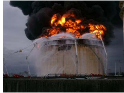
図 29 2003 年十勝沖地震の苫小牧市における浮屋根が沈没したナフサタンクにおいて、地震の 2 日後に発生したタンク全面火災 (消防庁提供: http://www.fri.go.jp/bosai/tokachi_lpgn.html )
