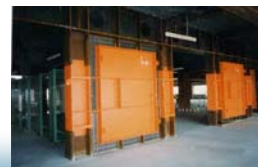
制震補強の例
