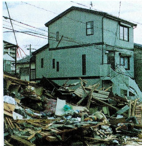
(阪神大震災全記録、毎日ムックより)
