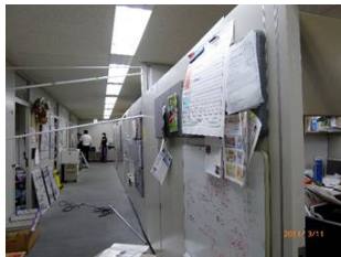
倒壊しそうになった間仕切り壁(24階:固定していない室内の重い本棚が間仕切り壁を押した)
