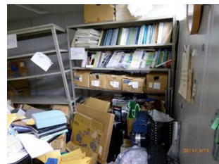
倒壊しそうになった間仕切り壁(24階:固定していない室内の重い本棚が間仕切り壁を押した)
