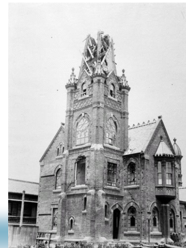
レンガ建築や煙突(組石建築)の被害
