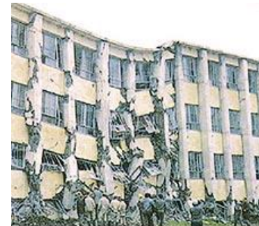
1968年十勝沖地震 (RC造被害) 1978年宮城県沖地震 (ピロティ被害)
