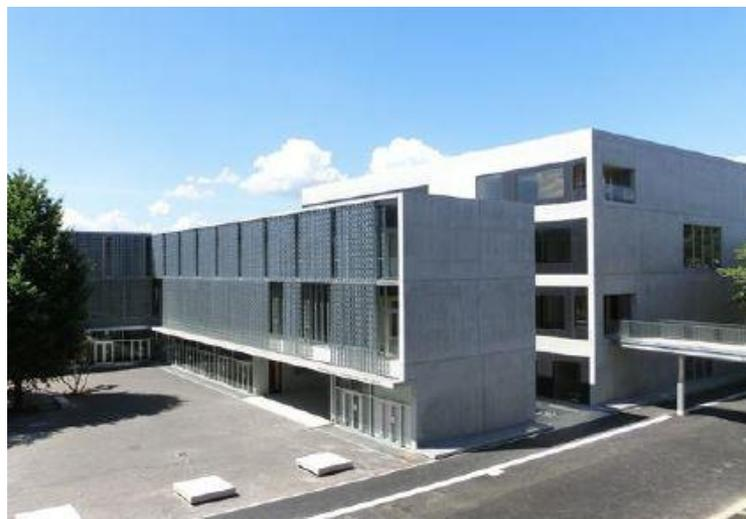
総合教育棟は真北から時計回りに25°回転しており、設置した地震計は建物に平行に設置されている。
