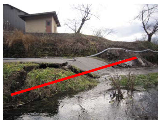
写真13 城山地区における地表地震断層 (断層を実線で記載)
