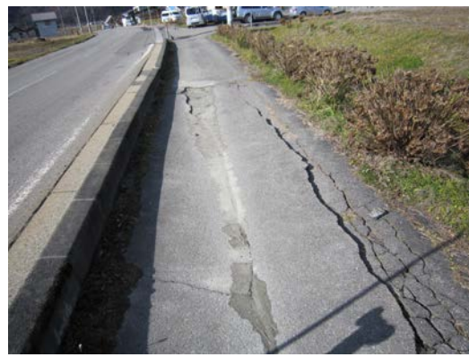
写真2 アスファルト亀裂からの噴砂
