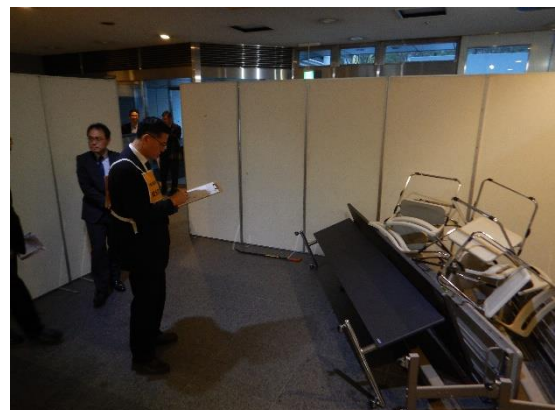
写真2 建物被害状況確認・記録
