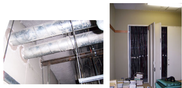
図 5 左図：D1 天井裏 右図：D3 配電盤
