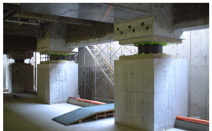
写真2 改修後の免震層（山梨県庁舎本館耐震改修工事より）
