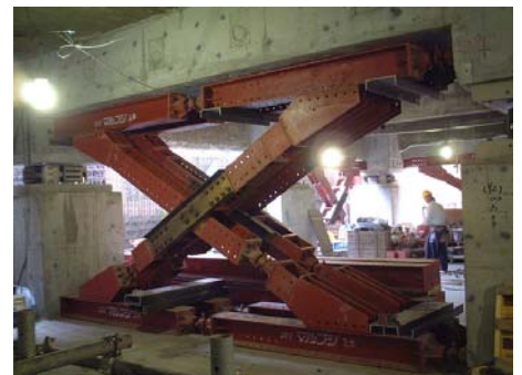
写真4 免震工事中の地震対策 (山梨県庁舎本館耐震改修工事より)
