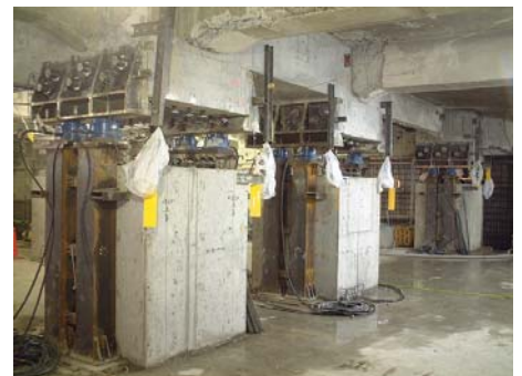
写真3 仮受け施工中の免震層 (山梨県庁舎本館耐震改修工事より)
