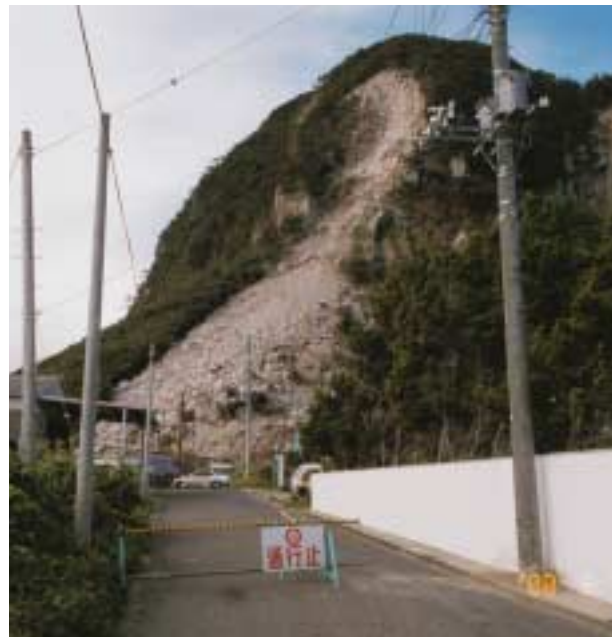
図 15：新島本村二丁目の崖崩れの状況
