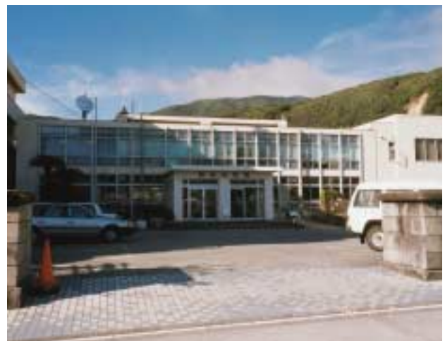
図 20：新島村役場庁舎（無被害）
