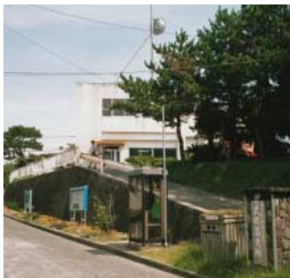
図 34：新島村役場式根島支所（無被害）
