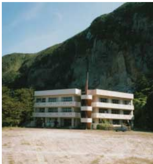
図 23：新島村立若郷小学校の全景と崖崩れした裏山
