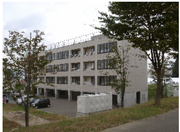
写真-14 県職員住宅外観(十日町市北新田、NIG021のすぐ横、無被害～軽微。住人から張間方向の揺れがひどかったとの証言があった)
