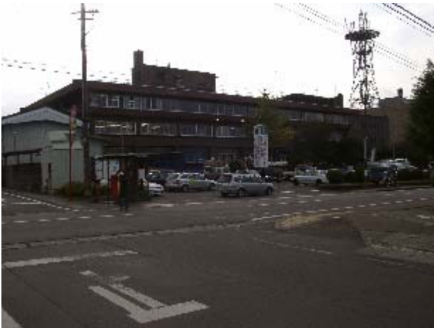
写真-22 十日町市役所の外観(十日町市千歳、軽微)
