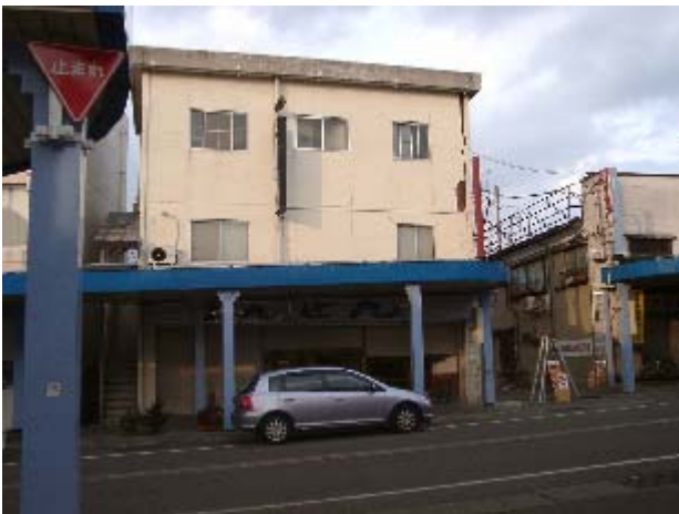
写真-29 コモ通り商店街の被害建物の外観
