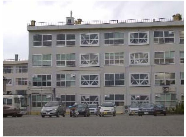
写真-18 十日町高校外観（K プレース補強）
