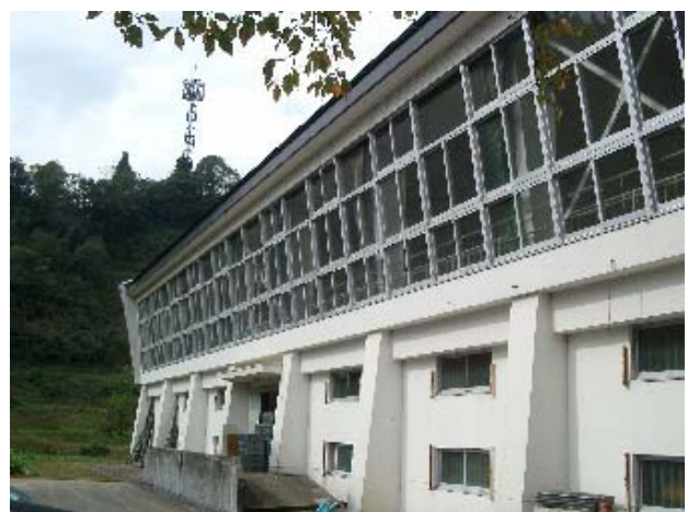
写真-2 大島小学校体育館(無被害)
