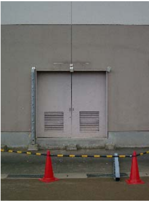
写真-37 雪囲い受け材の脱落
