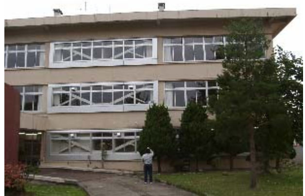
写真-6 K型補強ブレースの状況
