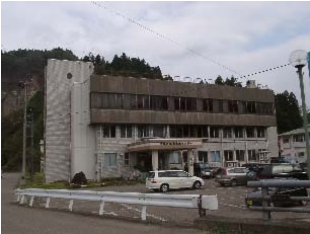
写真-3 大島公民館全景(大島村大平)、無被害
