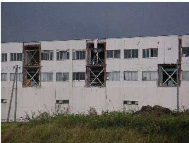
写真-38 鉄骨造建物の全景(川西町)外壁ALC版, ペントハウスに被害(詳細は写真-39,40)
