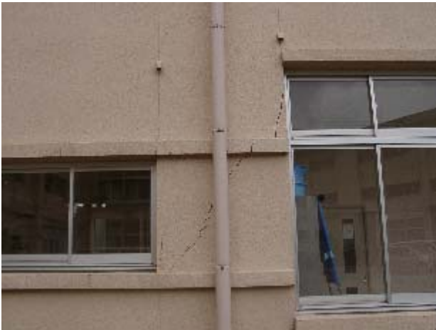
写真-10 短柱のせん断破壊（ひび割れ幅 5mm 程度、K型ブレースで補強されていた建物です。診断では第2種構造要素とはならず排除されていたものと思われる）
