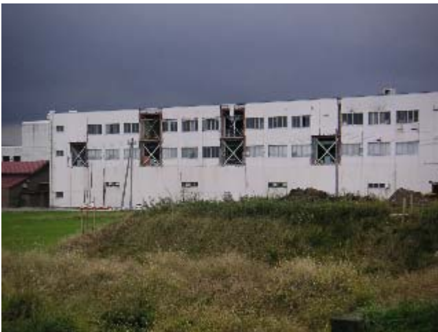
写真-37 雪囲い受け材の脱落
