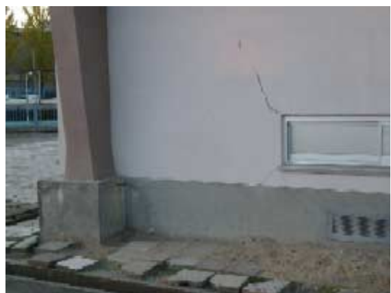
写真-27 RC壁開口周辺のひび割れ
