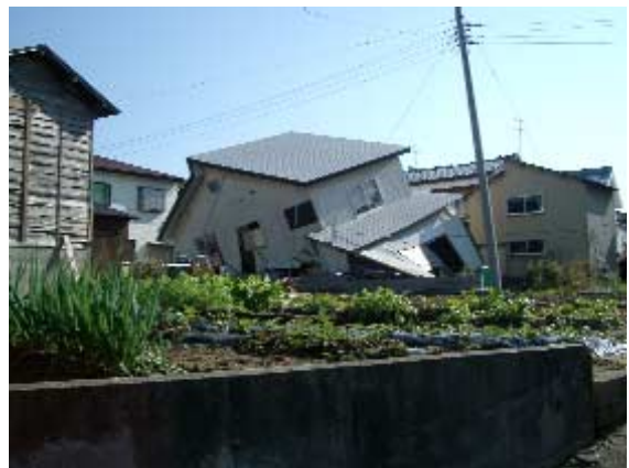
写真-16 六日市小学校近隣の住宅の被害③
