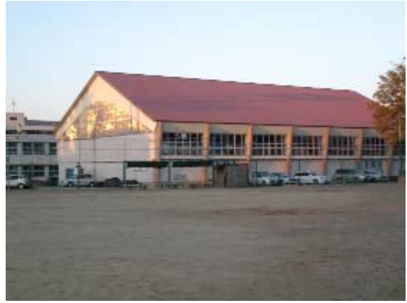
写真-26 宮内中学校体育館（長岡市宮栄）RC部分のひび割れ等軽微な被害（→次の写真）。
