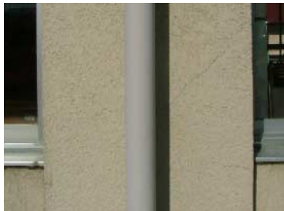
写真-4 柱のせん断ひび割れ
