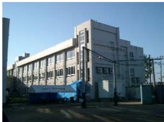
写真-21 上組小学校校舎（長岡市豊詰町）腰壁により短柱化した柱のせん断ひび割れなどの被害あり。（→ 次の写真）
