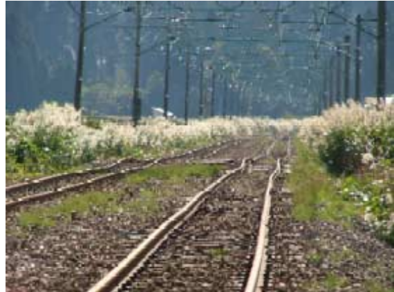
写真-8 上越線路盤の被害（長岡市滝谷町）
