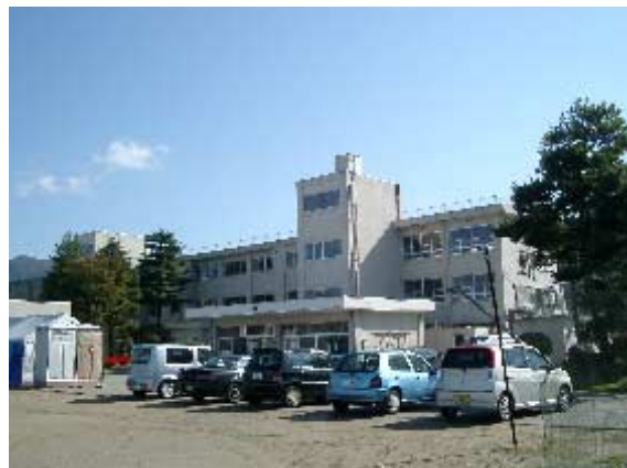
写真-3 岡南中学校校舎（長岡市十日町）柱のせん断ひび割れ（→ 次の写真），連層耐震壁の曲げひび割れ等の被害あり。
