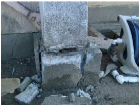
写真-7 柱脚部コンクリートの被害。
