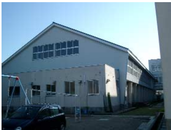
写真-18 十日町小学校体育館（長岡市十日町）屋根ブレース端部接合高力ボルト破断1箇所（→ 次の写真）、同高力ボルトのすべり数カ所、柱脚部にも被害あり。
