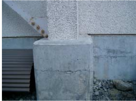
写真-20 柱脚部コンクリートひび割れ
