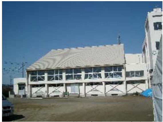
写真-10 山谷沢小学校体育館（長岡市滝谷町）屋根ブレースの座屈。（→ 次の写真）
