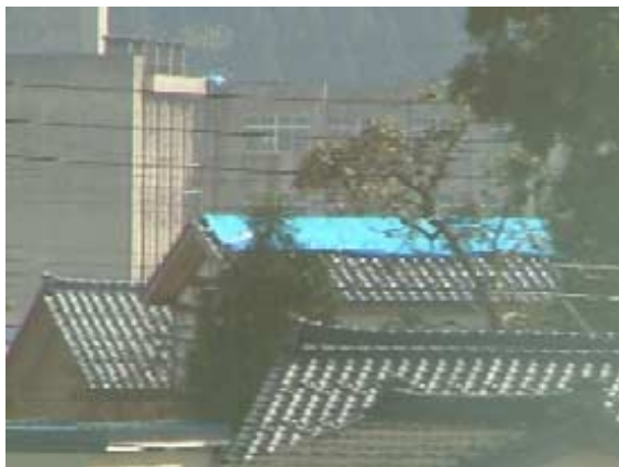
写真-1 瓦屋根の被害（国道17号線長岡東バイパス亀貝IC付近）
