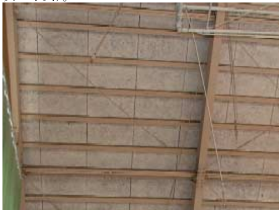
写真-6 屋根ブレース端部接合部ボルト破断，ブレース脱落
