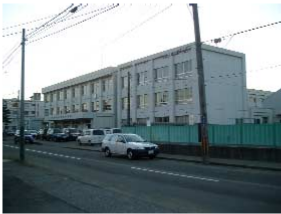
写真-24 宮内小学校校舎（長岡市見宮栄）柱曲げひび割れ等軽微な被害。
