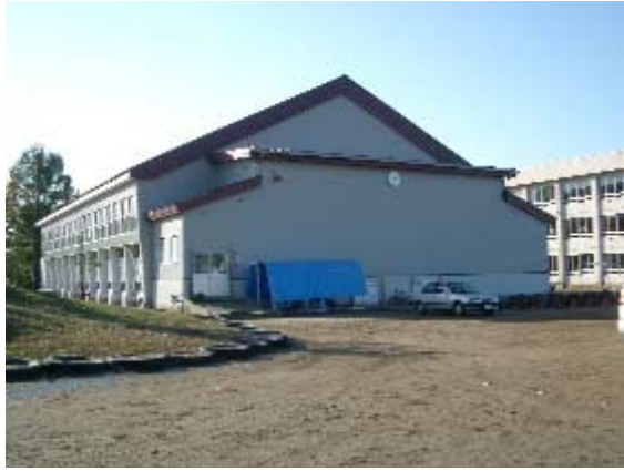
写真-23 上組小学校体育館（長岡市豊詰町）耐震補強済，被害なし。
