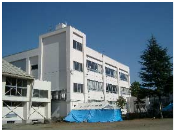
写真-9 山谷沢小学校校舎(長岡市滝谷町)柱に軽微な被害。
