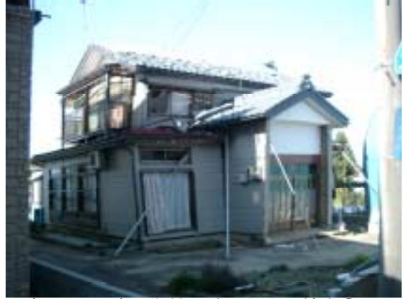
写真-14 六日市小学校近隣の住宅の被害①
