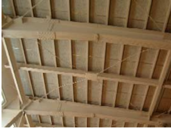
写真-11 屋根ブレースの座屈
