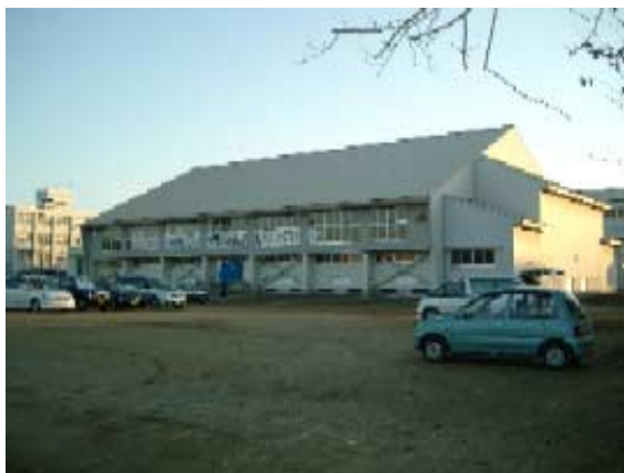
写真-25 宮内小学校体育館（長岡市宮栄）目立った被害なし。
