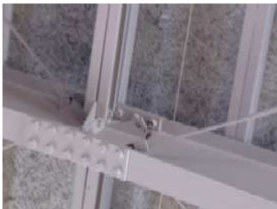
写真-19 屋根ブレース端部ボルト破断
