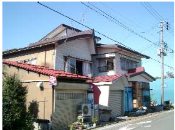
写真-15 六日市小学校近隣の住宅の被害②
