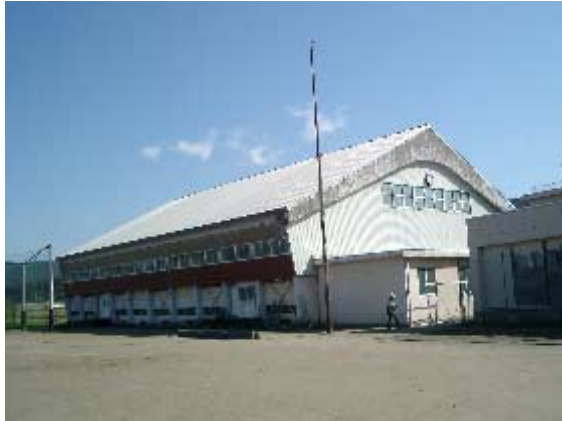
写真-5 岡南中学校体育館(長岡市十日町)屋根ブレース，柱脚部コンクリート等に被害あり（→次の写真）。
