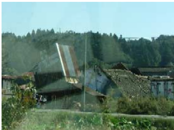
写真-2 古い建物の倒壊（国道17号線長岡東バイパス高畑IC付近）
