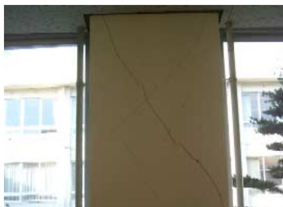
写真-22 腰壁により短柱化した柱のせん断ひび割れ
