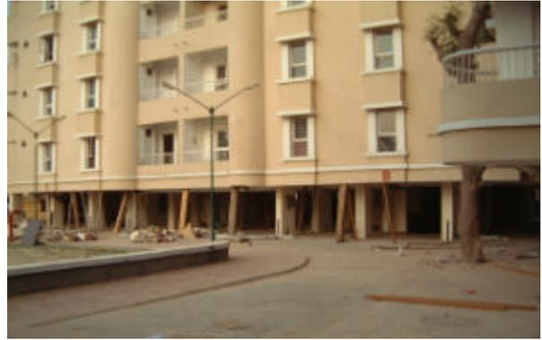
写真6 木材による軸力保持（応急措置）
