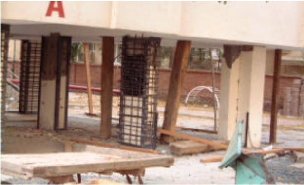
写真5 ピロティ部分の応急補強
