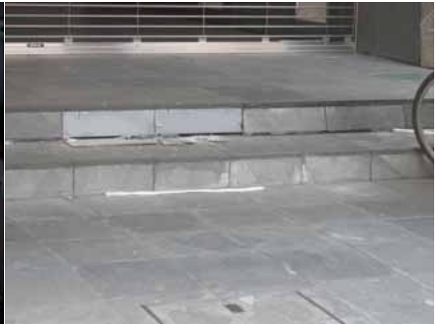
8 免震建物 エントランス部分
