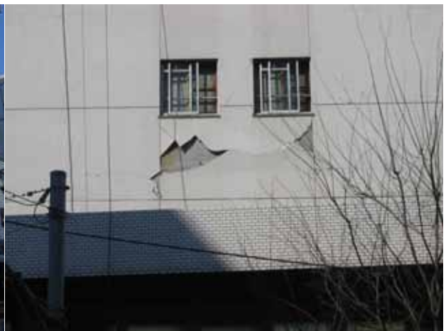
9 外壁損傷
