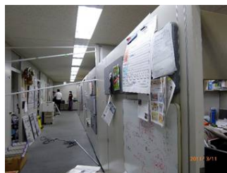
倒壊しそうになった間仕切り壁(24階:固定していない室内の重い本棚が間仕切壁を押した)
