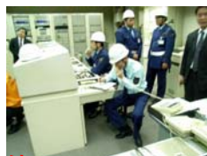
防災センター・警備室
