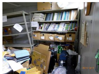
倒壊しそうになった間仕切り壁(24階:固定していない室内の重い本棚が間仕切壁を押した)
