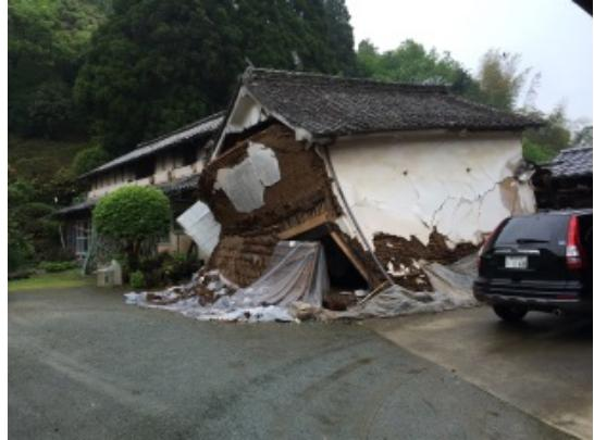
写真4.2-2 倒壊した土蔵
