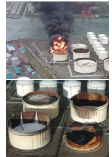
苫小牧の石油タンクの被害
