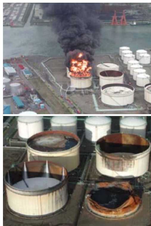
苫小牧の石油タンクの被害
