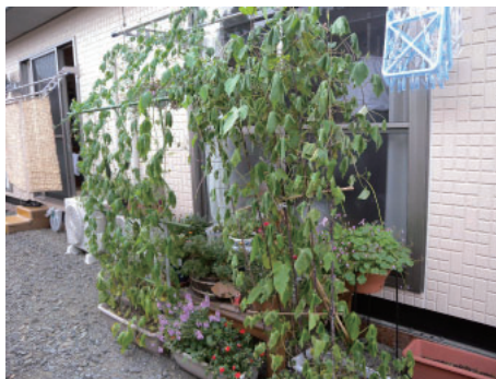
写真3 植栽による日射遮蔽の工夫
