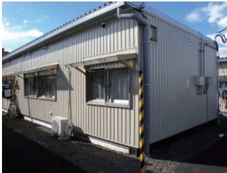
2011年10月以降、冬に備えて風除室の設置や妻側・南側壁面に付加断熱工事、南側窓の二層化が施された。
