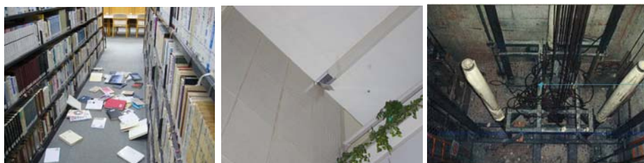
2F (図書館:蔵書の散乱) 1F (アトリウム:EPJパネルの被害) エレベーターケーブルの絡まり (本学の写真ではありません)
