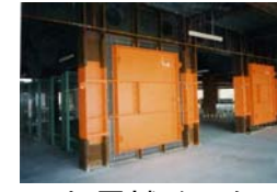
制震補強の例
