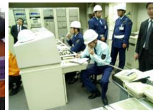
防災センター対応訓練(地下)
