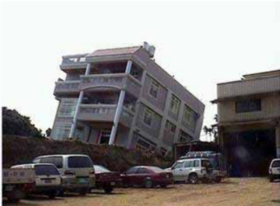
写真1 集集地震における地表断層直上による建物被害
