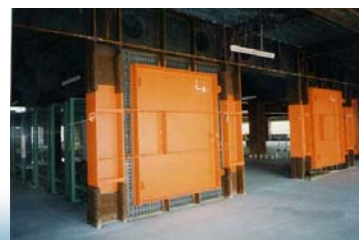
制震補強の例
