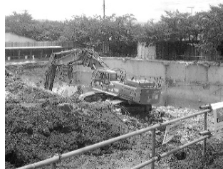
b) 排水処理施設解体現場
