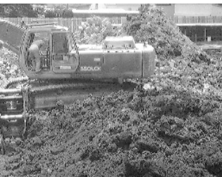
c) 解体時汚泥集積現場
