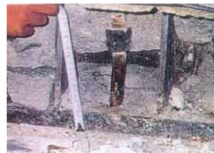
図11 アンカーボルト拔出<sup>3)</sup>
