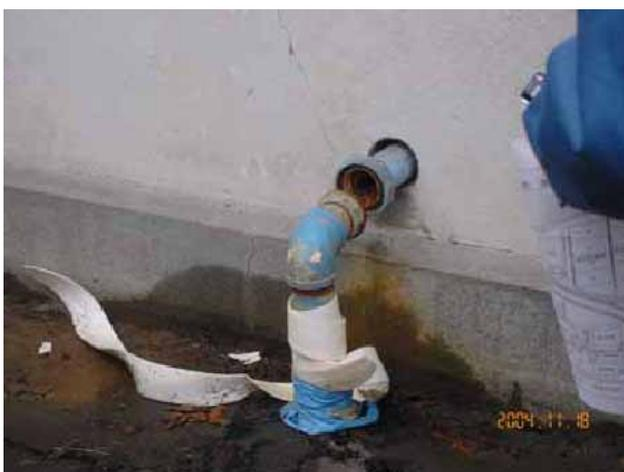
写真 9：中越地震における構造物との取り付け部位における配管の破断
