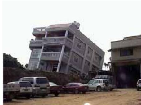
図7 1995年兵庫県南部地震における神戸市の木造家屋の倒壊(左)と1999年台湾・集集地震による地表断層上のRC建物の傾斜(撮影:久田)
