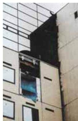
図 2 PC カーテンウォールの被害
