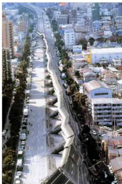
写真2：高速道路の被害
