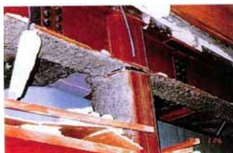
図9 隅肉溶接破断<sup>3)</sup>
