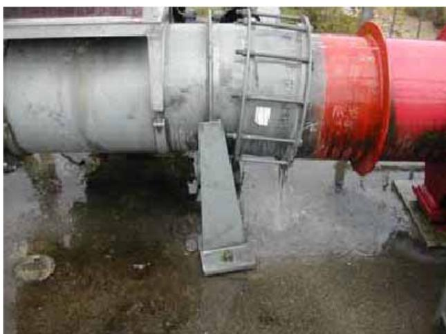
写真 8：中越地震における水管橋の伸縮管とリングサポートの変形
