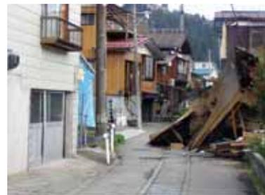
写真8 住宅傾斜・倒壊による二次災害
