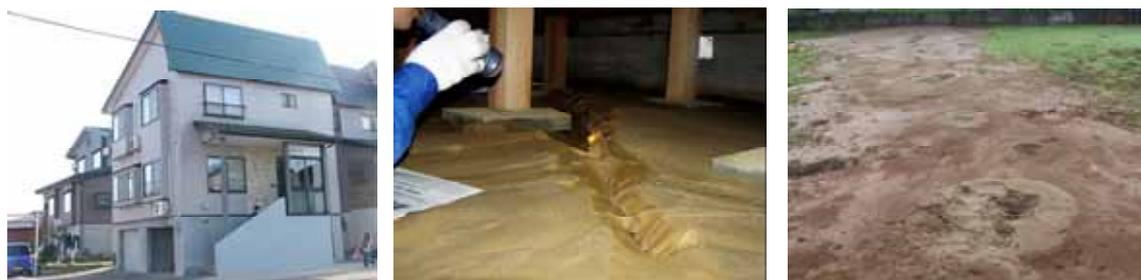
住宅沈下（沈下量 118mm）
