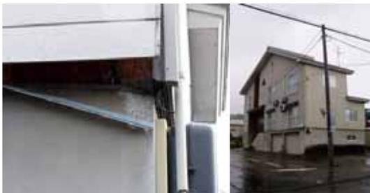
写真 6 混構造の典型的な被害
