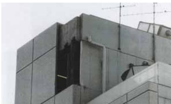
図 1 PC カーテンウォールの被害
