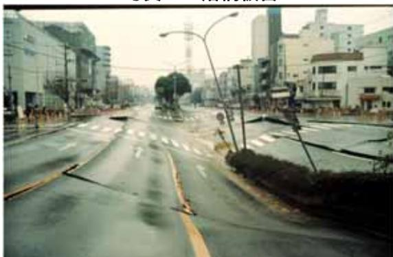
写真 6：地下鉄被害による道路陥没
