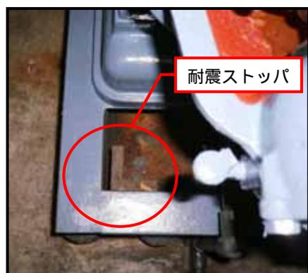
写真3 耐震ストップを防振架台内側に取り付けた例(工学院大学の揚水ポンプ)
