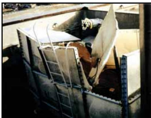
写真1 スロッシングによる高置水槽の天板及び側板の破損<sup>出典1)</sup>
