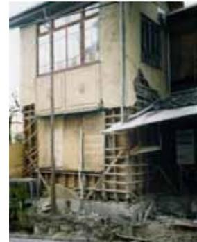
写真4 腐朽による被害
