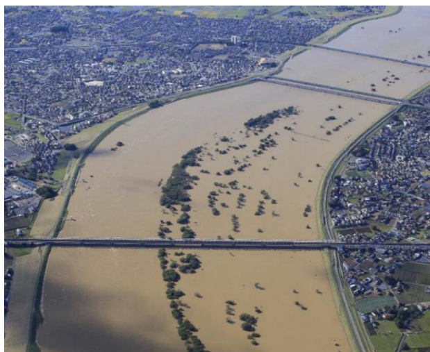
氾濫危険水位を越した利根川栗橋地点
