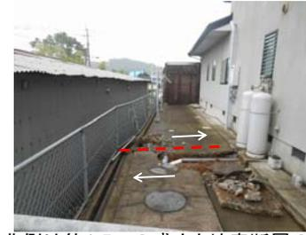
北側は約1.5mの盛土と地表断層のずれ(布基礎・耐震壁で基礎・建物は変形せず)
