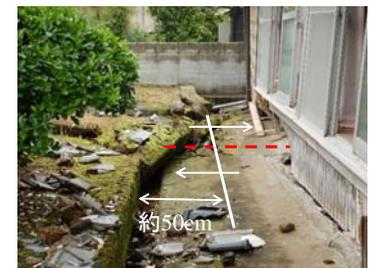
断層のずれによる建物変形(北面)
