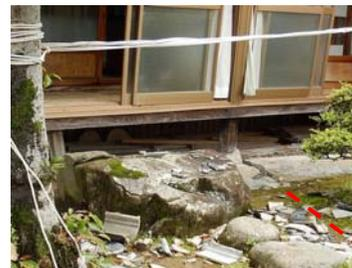
地表地震断層と東基礎・柱のずれ(南面)
