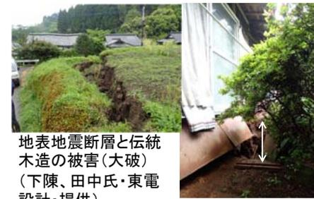
地表地震断層と伝統木造の被害(大破)
