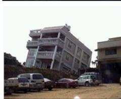
1999年台湾・集集地震による地表断層上のRC建物の傾斜
