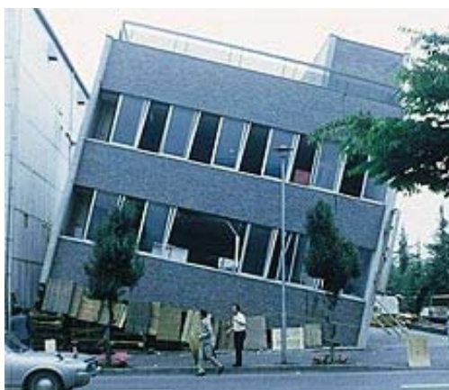
図 9 宮城県沖地震によるピロティー建物の被害 ( http://www.kajima.co.jp/tech/seismic/higai/030604.html )
