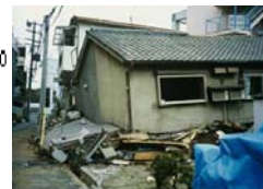
1995年兵庫県南部地震における神戸市の木造家屋の倒壊 →震度7、なぎ倒す
