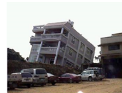
1999年台湾・集集地震による地表断層上のRC建物の傾斜 →移動・傾斜
