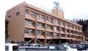
耐震補強の例 http://bousai.kke.co.jp/management/2005/08/post_1.html
