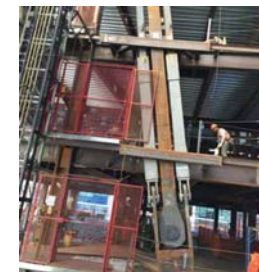
BRB(Buckling-restrained brace) とdamperを導入したmega-brace
