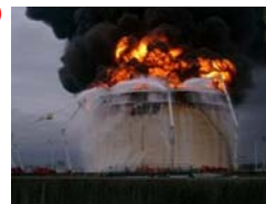
2003年十勝沖地震の苫小牧市におけるナフサタンクの全面火災 →卓越周期・長い継続時間
