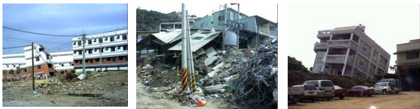
1999年台湾・集集地震における地表断層直上の建物の被害例(逆断層)
