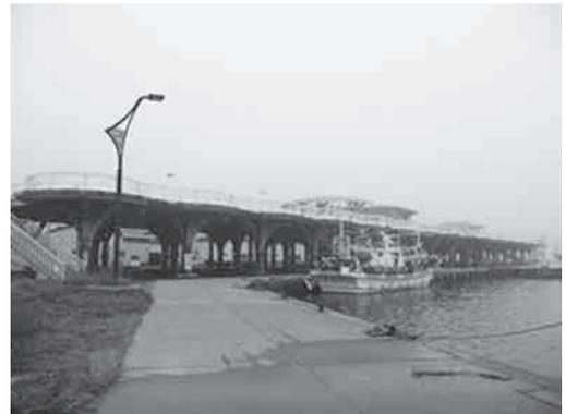
(港傍の「望海橋」は、高さ約7mの人工地盤である。2,000人以上が避難できる奥尻町の安全・安心対策の象徴であるが、普段はわずかな漁具が目立つ程度で、閑散としている。)
