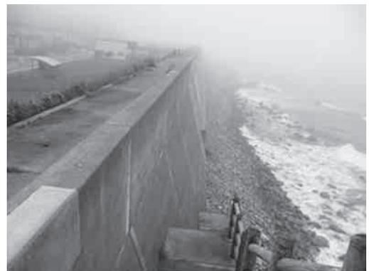
(総延長14kmにおよぶ防潮堤は、最高10mを超える高さで津波から街を守る。しかし、風光明媚な海岸線が一変したため、観光業に少なからぬ打撃を与えたのは間違いない。)
