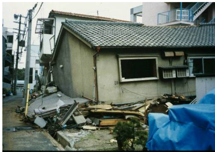
図5 1階の壁不足による木造家屋の被害
