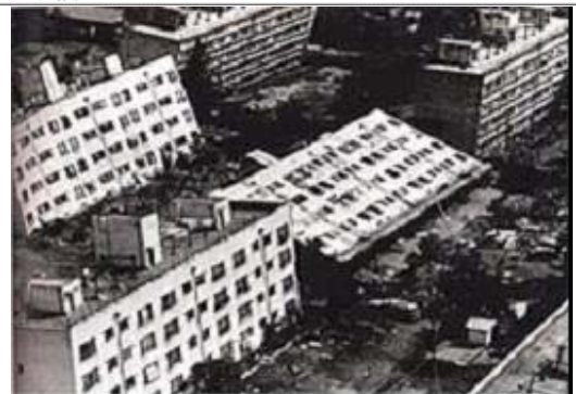
図 6 新潟市川岸町アパートの加速度記録と被害 ( http://www.city.yokohama.jp/me/bousai/ekijouka_map/q&a.html )
