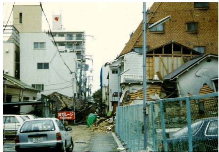
図8 液状化被害（左、ポートアイランド）と倒壊家屋による道路閉塞（右）
