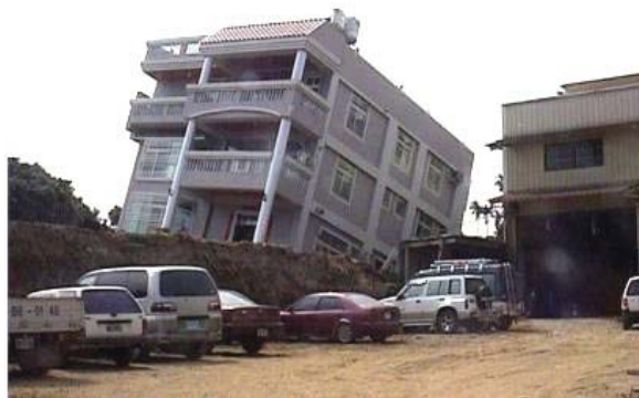
図11 台湾集集地震で出現した地表断層と傾斜したRC建物（軽微な被害）
