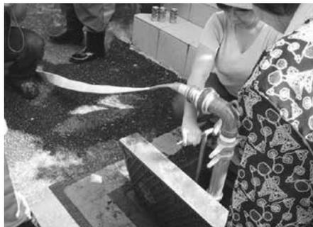
写真1 道路の消火栓を利用した初期消火訓練の様子。消火栓の蓋を開け、スタンドパイプを挿し、ホースをつなぎ、バルブを明けると強い水圧の散水が可能になる(北区上十条五丁目の防災訓練より)。
