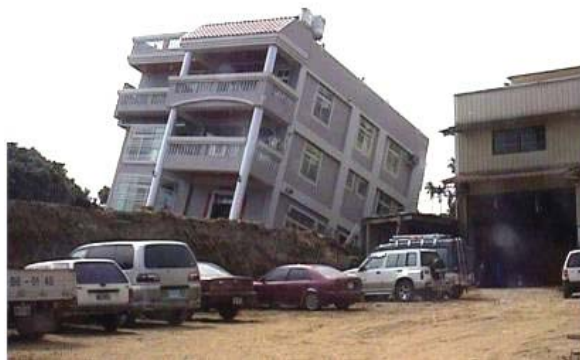
図11 台湾集集地震で出現した地表断層と傾斜したRC建物（軽微な被害）
