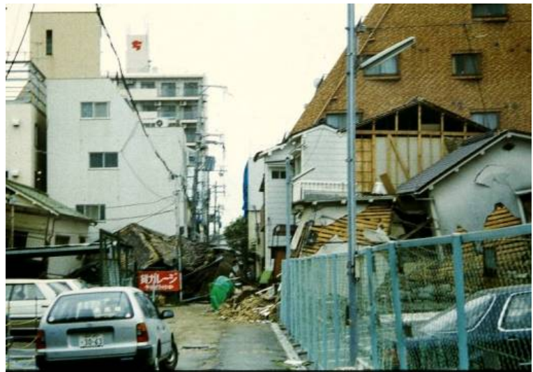
図 9 液状化被害（左、ポートアイランド）と倒壊家屋による道路閉塞（右）
