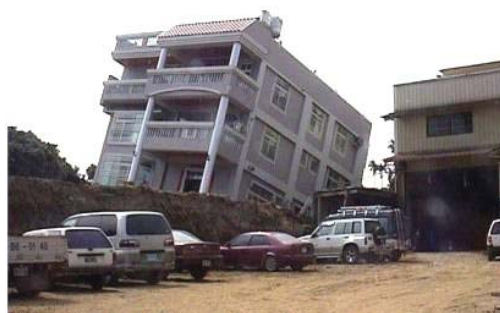
図 14 台湾集集地震で出現した地表断層と傾斜した RC 建物（軽微な被害）
