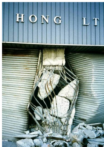
図7 旧基準のRC造建物の柱のせん断破壊（左）と中間層破壊（上）
