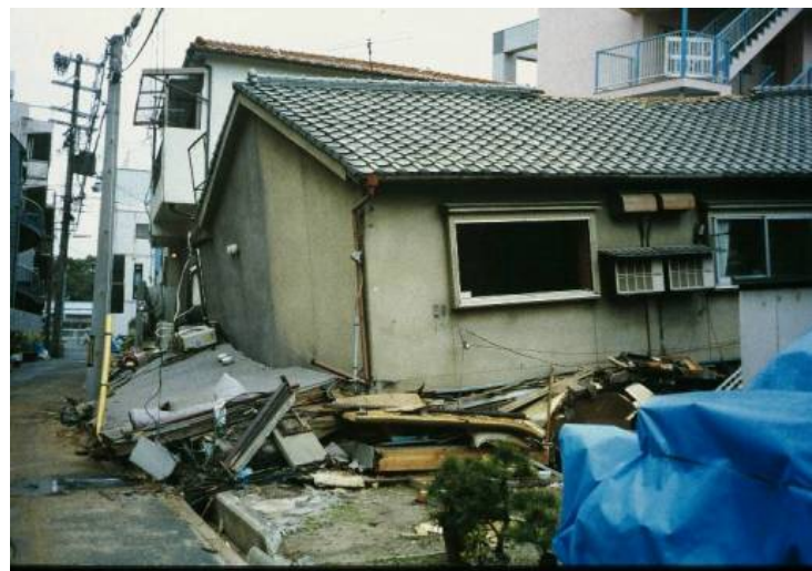
図6 1階の壁不足による木造家屋の被害
