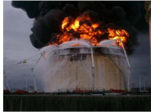
図 29 2003 年十勝沖地震の苫小牧市における浮屋根が沈没したナフサタンクにおいて、地震の 2 日後に発生したタンク全面火災 (消防庁提供: [http://www.fri.go.jp/bosai/tokachi\\_lpgn.html](http://www.fri.go.jp/bosai/tokachi_lpgn.html))
