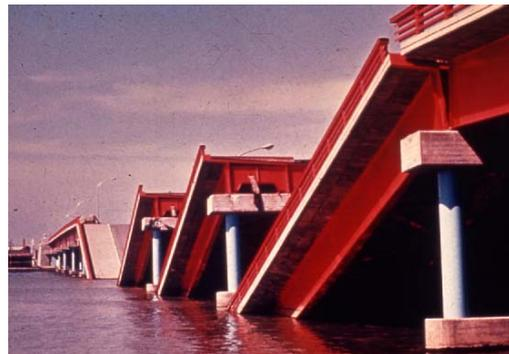
図 30 1964 年新潟地震の液状化による被害 (左: 川岸町アパートの倒壊、右: 昭和大橋の落橋)
