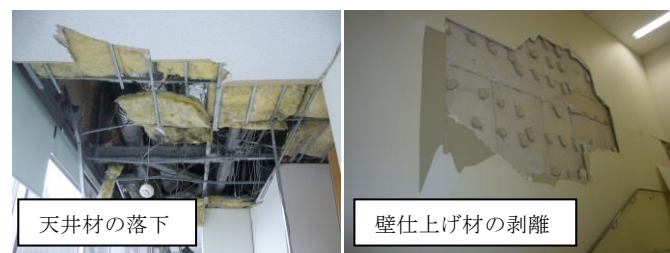
写真2 訓練に使用した建物被害状況写真の一部
