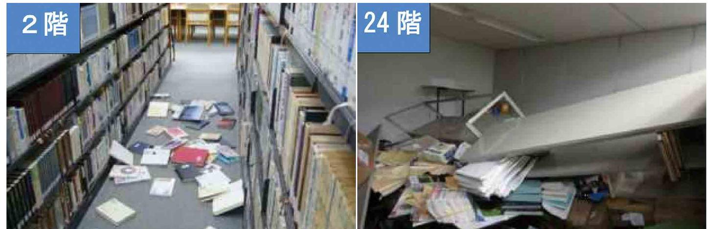
東日本大震災の際、長周期地震動を受けた東京都内のビル内。高層階のほうが大きく揺れ、家具類の転倒や天井の落下などの被害が発生した
