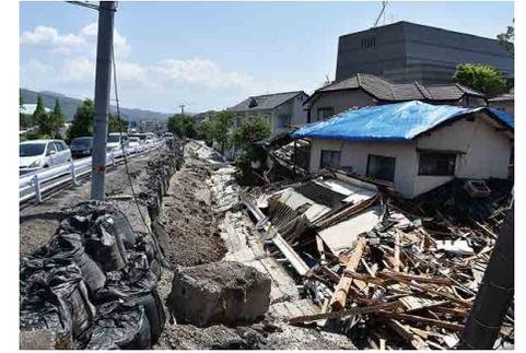
道路地盤が住宅地に向かって擁壁ごと崩壊。熊本地震、益城町
