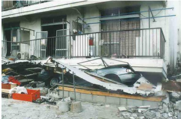
1階が崩壊して車を押しつぶしたRC造の集合住宅。阪神・淡路大震災、神戸市
