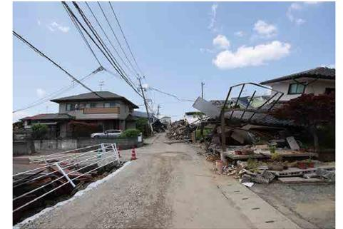
地盤の流動で道路がひび割れ、電柱が倒壊。左の家は、外見上は無被害。熊本地震、益城町
