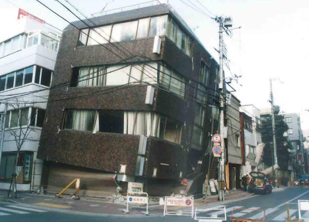
1階がつぶれて斜めに傾いたRC造4階建てビル。阪神・淡路大震災、芦屋市
