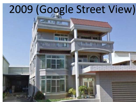
1999年台湾集集地震の断層変位 で傾斜と修復したRC建物(久田)
