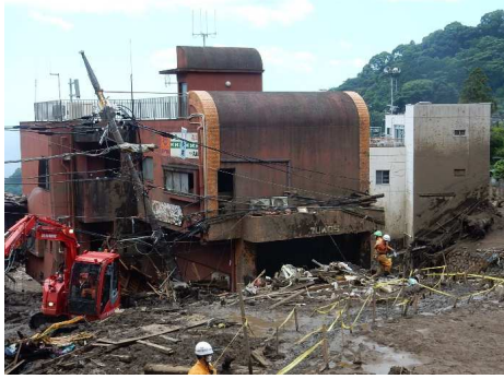
2021熱海市に土石流 に耐えたRC造建築(久田)
