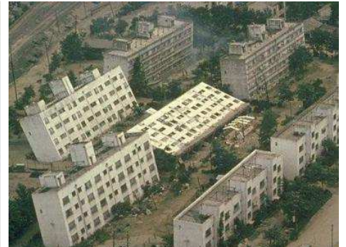
1964年新潟地震の液状化で転 倒したRC造建物(死者無し)
