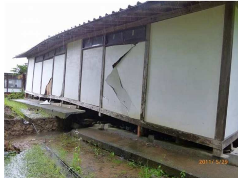
2011年福島県浜通り地震の 断層変位に耐えた木造建物(久田) 2009 (Google Street View)
