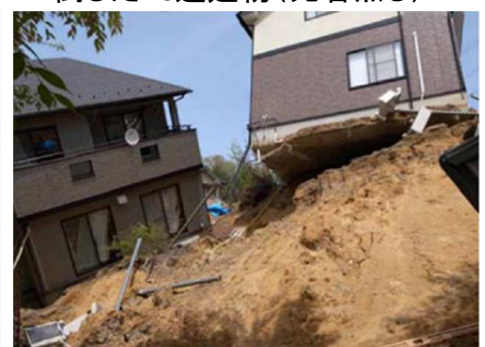
2011東日本大震災の地すべりに 耐えた木造住宅(釜井2019)
