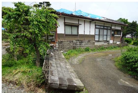
「コンクリートブロック塀の傾斜危険、瓦の落下注意」で危険判定(2016年熊本地震)
