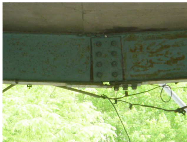
梁下フランジ添え板の孔欠損部破断
