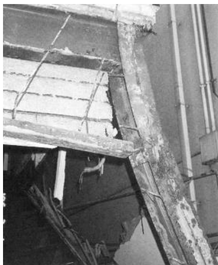
柱の全体座屈(左)と柱頭の局部座屈(右) (1995年兵庫県南部地震)
