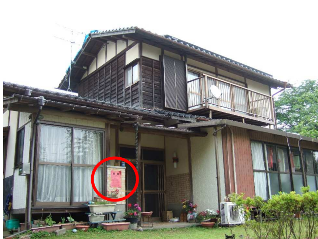
「隣接する崖地上の建物が崩壊し、危険が及ぶ可能性あり」で危険判定(2016年熊本地震)
