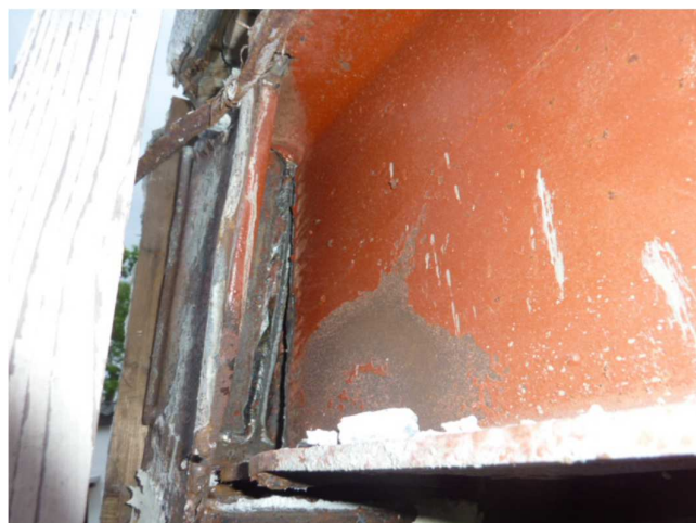
梁端部の破断
