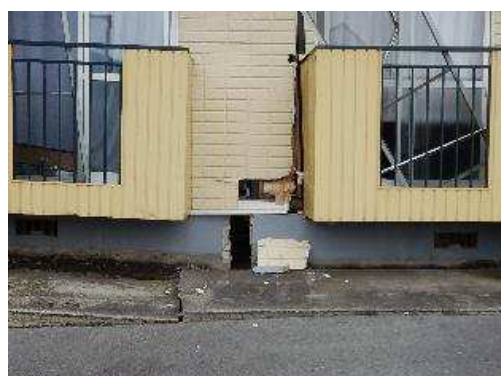
断層変位による地盤変形と基礎の亀裂(左)と破断・躯体損傷(右)(2016年熊本地震)
