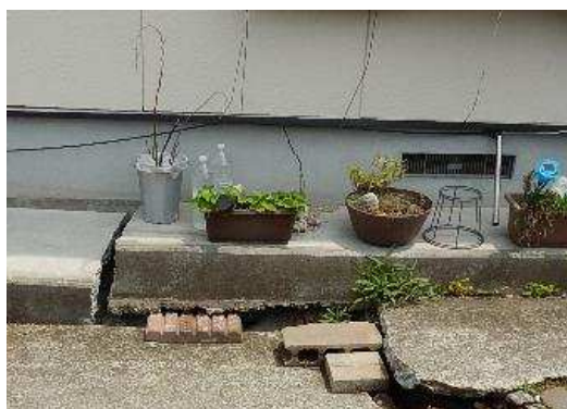
断層変位による地盤変形と基礎の亀裂(左)と破断・躯体損傷(右)(2016年熊本地震)
