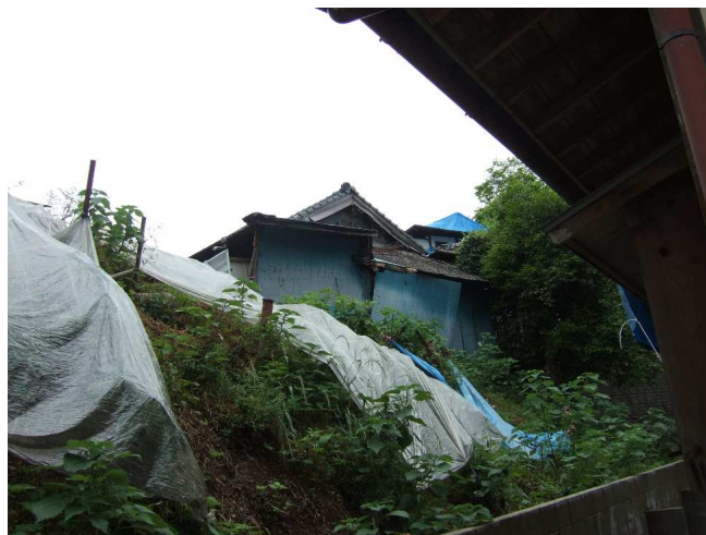
「隣接する崖地上の建物が崩壊し、危険が及ぶ可能性あり」で危険判定(2016年熊本地震)
