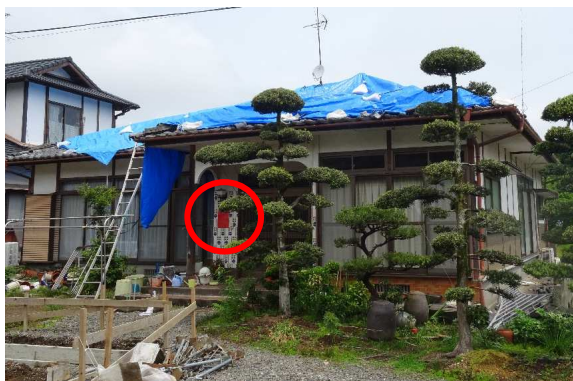
「コンクリートブロック塀の傾斜危険、瓦の落下注意」で危険判定(2016年熊本地震)
