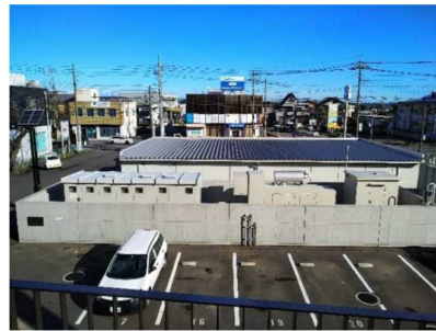
防水塀で囲われた電気設備 改修工事による止水板設置 (建築物における電気設備の浸水対策ガイドライン資料、国土交通省)
