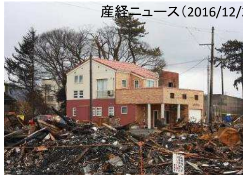
2016糸魚川大規模火災に耐えた木造住宅 ⇒防火構造、ダンパー付き換気扇、網入りガラスサッシなど
