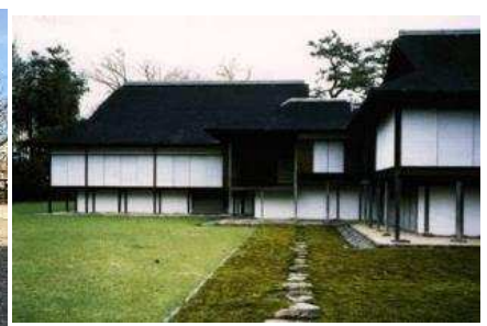
桂離宮の洪水対策(桂垣、 高床、着脱可能な建具) http://kanko.city.kyoto.lg.jp
