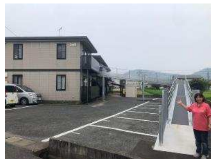
2018年7月豪雨の真備町浸水の後、 地元NPOが、スロープ設置等アパー ト兼・要援護者避難所に改築
