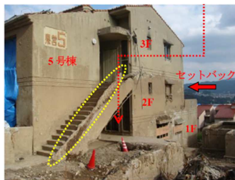
2014広島土砂災害時に土石流に耐えたRC集合住宅 (砂防ダムよりずっと安価、山本, AIJ大会-PD 2019)
