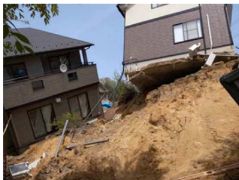
2011東日本大震災の地すべりに耐えた木造 住宅(釜井, AIJ大会-PD 2019)⇒断層変位
