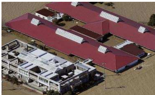
2019年東日本台風時の川越市の 特別養護施設(平屋棟から盛土上 の新築棟に全員避難)
