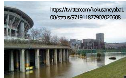
横浜国際総合競技場の高床式構造 (台風19号時に遊水地として活用、 翌日のラグビーWCの試合も開催)
