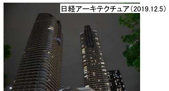
武蔵小杉タワーマンションの浸水・電気設備被害と生活障害⇒ガイドラインへ
