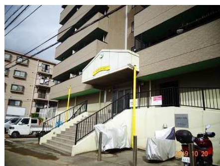
無被害の高床マンション (1階は堤防高さより高い)
