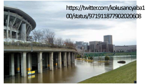
横浜国際総合競技場の高床式構造 (台風19号時に遊水地として活用、翌日のラグビーWCの試合も開催)
