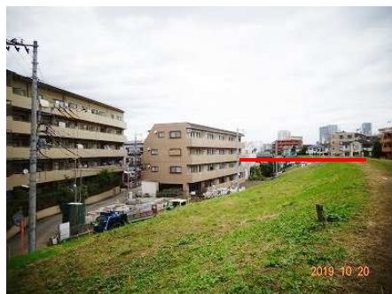
1階で犠牲者が出たマンション (堤防高さは3階床面あたり)
