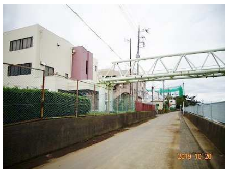
無被害の盛土上の公共施設 (堤防高さより高い)
