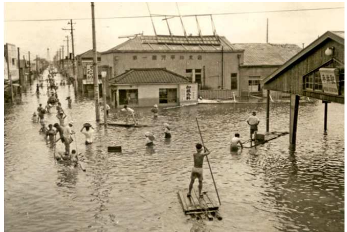
キティ台風で浸水した総武線平井駅(江戸川区)付近で避難する人たち(c)朝日新聞
