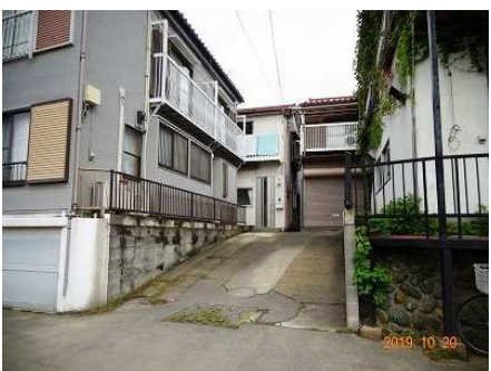
盛土・高床の無被害の宅地 (1階は堤防高さより高い)
