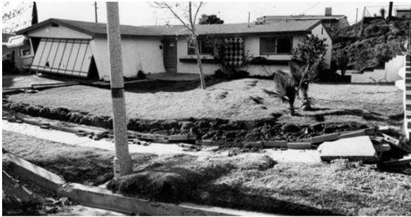
1971 San Fernando地震の断層変位による建物被害(写真: USGS)
