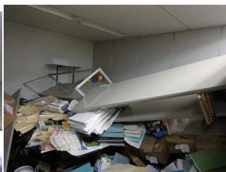
24F(本棚の転倒、間仕切り壁の変形)
