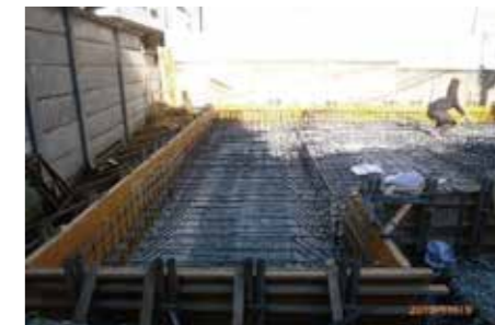
十分な鉄筋で補強したべた基礎
