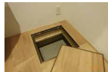
床下用の点検口
