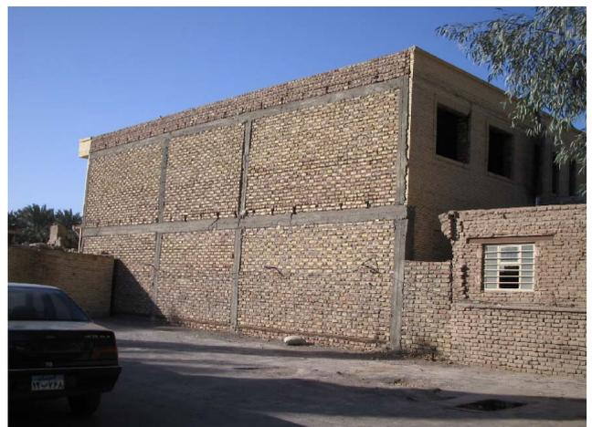
(d) RC フレーム補強組石造建築
