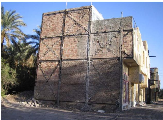
(c) 鉄骨フレーム補強組石造建築
